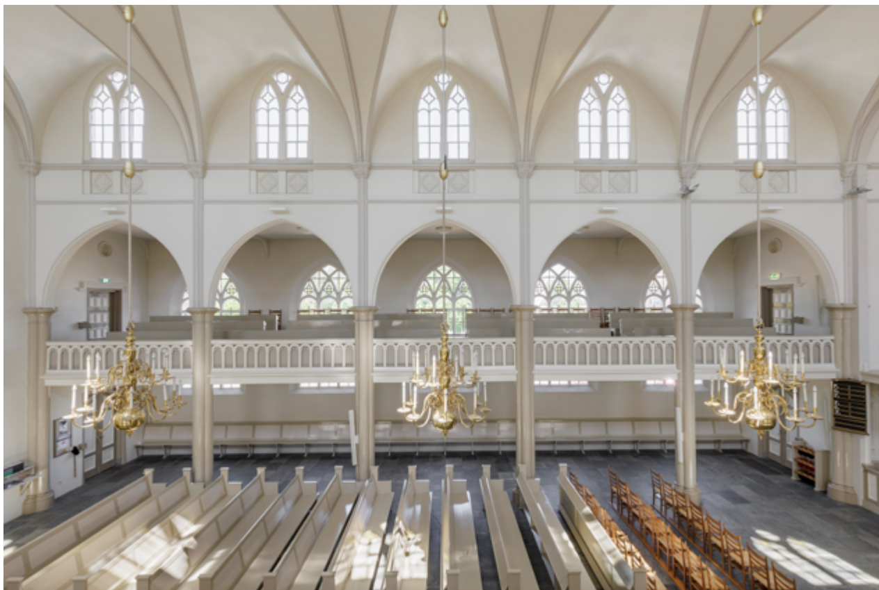
Doorsnede over het basilicale schip met de fragiele, open structuur van slanke kolommen en gewelfribben. De galerij in de zijbeuk geeft samen met de horizontale lijsten tegenwicht aan de verticaliteit.
