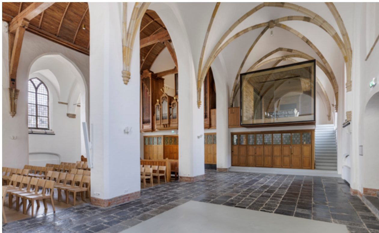
Onder leiding van Van Hoogevest Architecten werd de kerk in 2019-2020 gerestaureerd en verduurzaamd. Aan de westzijde van de noordelijke zijbeuk werd een nieuwe functionele ruimte ontworpen. Voor de wanden van deze ruimte werden delen van verwijderde kerkbanken hergebruikt.
